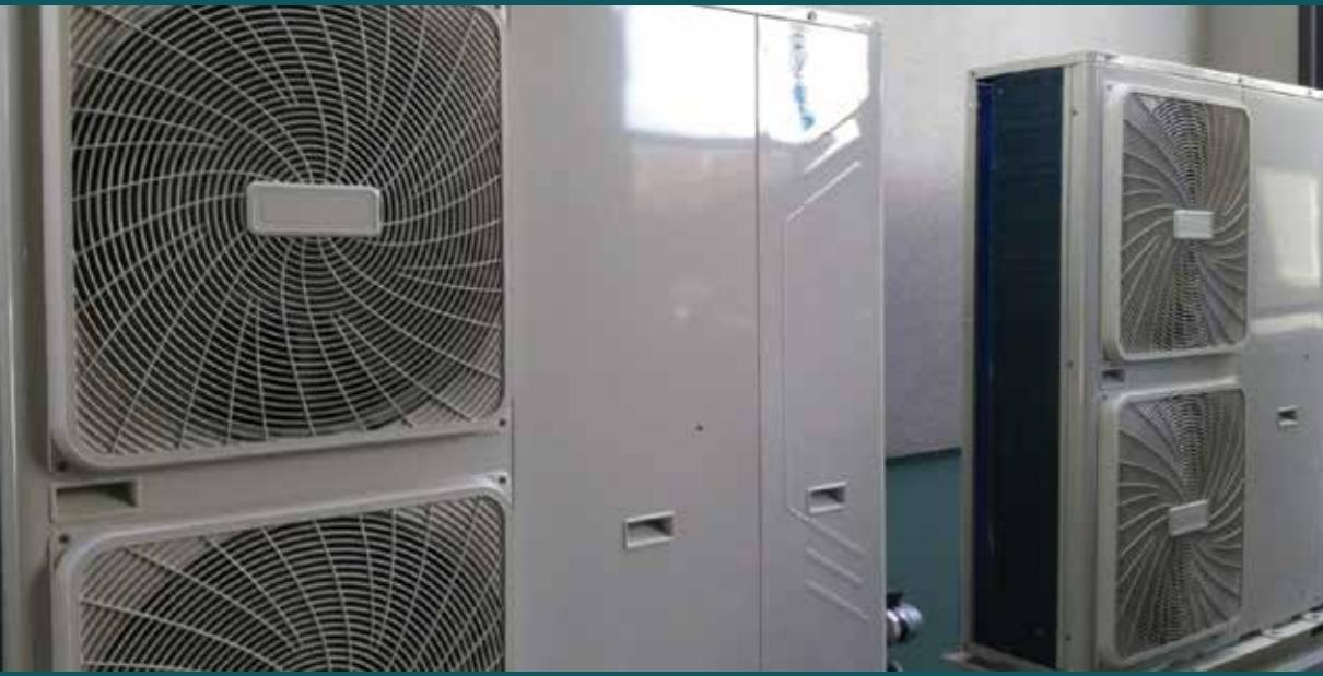
Ove tri pumpe rade uz pomoć odvojenih sistema i u odnosu na visinu spoljne temperature, uključuje se jedna, po potrebi druga a kada je ekstremno hladno aktivira se i treća pumpa i tako se postiže maksimalna ušteda energije . Ovi standardi kojih se pridržava Bio- elektrik se primenjuju i u Evropi na gradnji novih zgrada.
